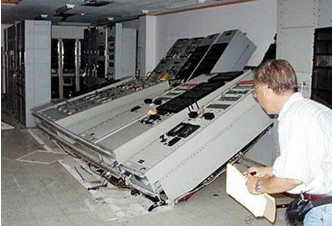
Abb. 2.13.1 und 2.13.2 &gt; Umgekippte Steuerschränke
