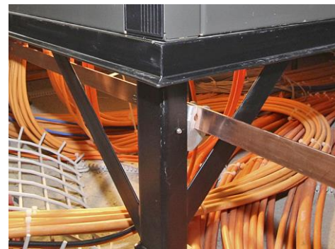
Abb. 2.3.8 > Horizontale Stabilisierung durch Diagonalstreben
