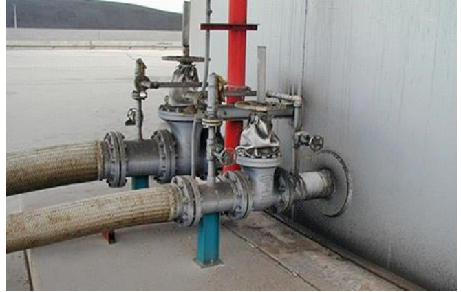
Abb. 2.17.6 > Flexibler Leitungsanschluss
