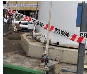
«Elefantenfuss» an ungenügend verankertem Benzintank
