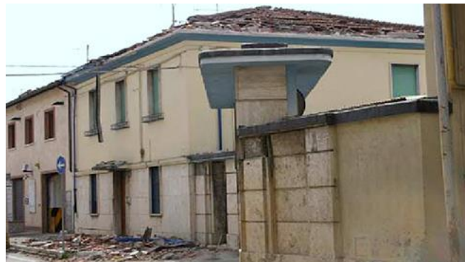
Abb. 2.10.2 > Heruntergefallene Dachziegel
