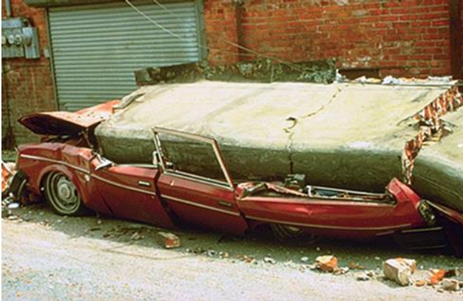
Abb. 2.6.1 und 2.6.2 > Versagen infolge Trägheitskräften quer zur Brüstungsebene
