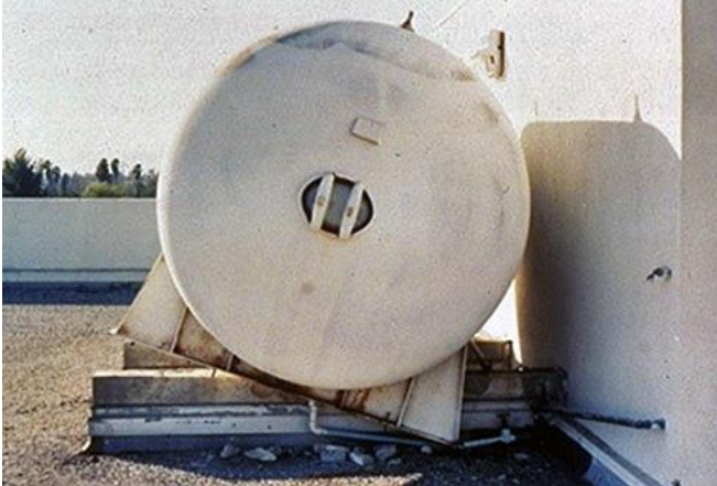
Abb. 2.17.1 und 2.17.2 &gt; Trägheitsversagen bei Tankwänden
