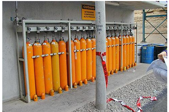
Abb. 2.17.8 > Befestigung von Zylinderflaschen
