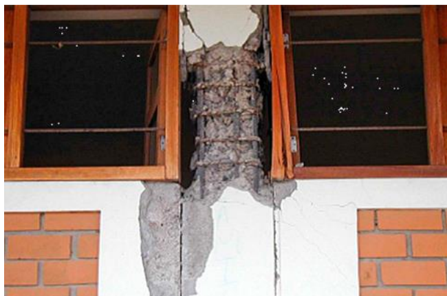
Abb. 2.4.2 > Schubbruch in kurzer Stütze bei Mauerwerksausfachung
