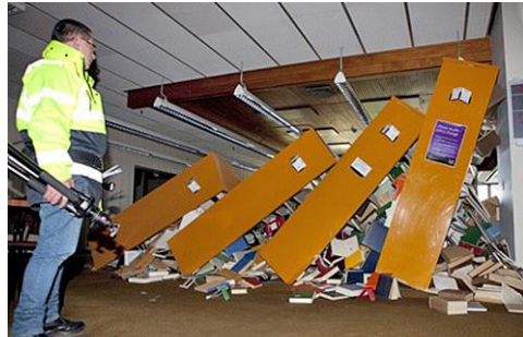
Abb. 2.22.5 und 2.22.6 &gt; Kippen mehrerer Regalreihen infolge des Domino-Effekts
