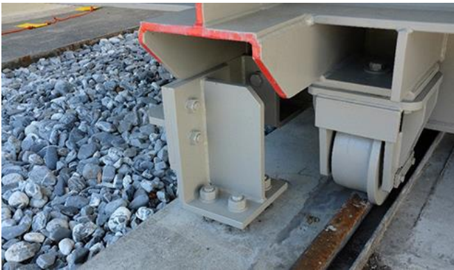
Abb. 2.14.3 &gt; Verankerung eines Transformators auf Fahrrollen
