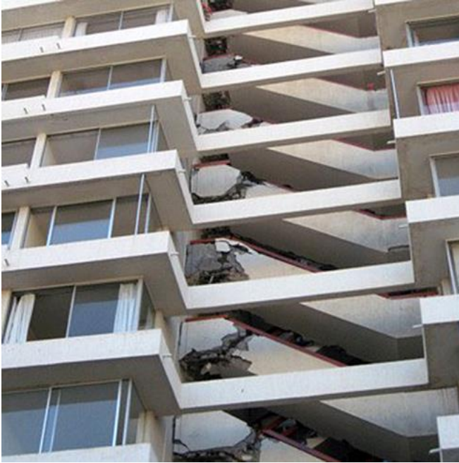
Abb. 2.7.1 und 2.7.2 &gt; Druckdiagonalen im Treppenlauf
