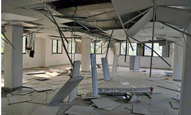
Abb. 2.15.1 und 2.15.2 &gt; Absturz von Beleuchtungselementen
