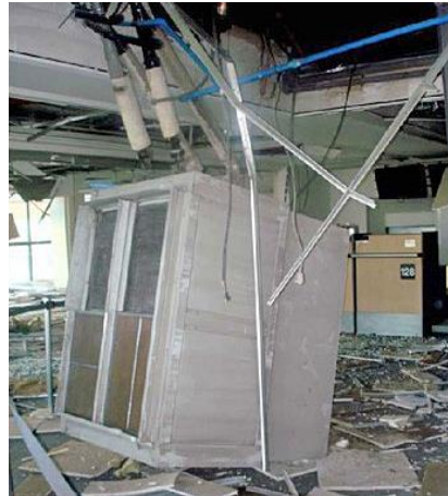
Abb. 2.16.2 &gt; Ungenügend ausgesteiftes Element
