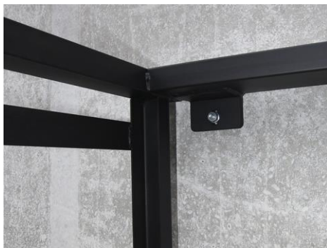
Abb. 2.3.7 > Befestigung Grundrahmen an Wand
