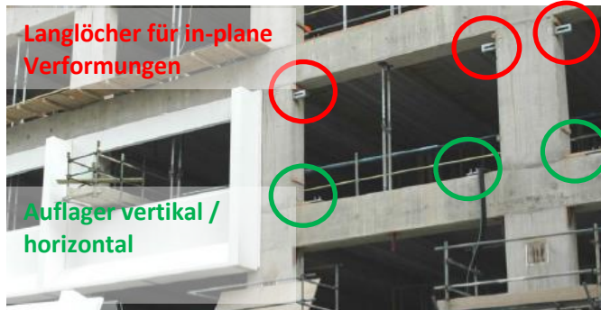
Abb. 2.5.5 > Befestigung von Fassadenelementen mit Langlöchern
