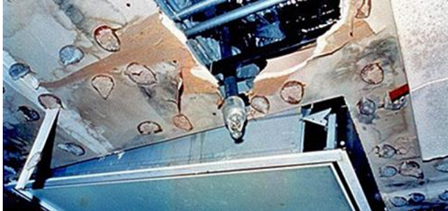
Abb. 2.12.1 und 2.12.2 > Beschädigter Sprinklerkopf
