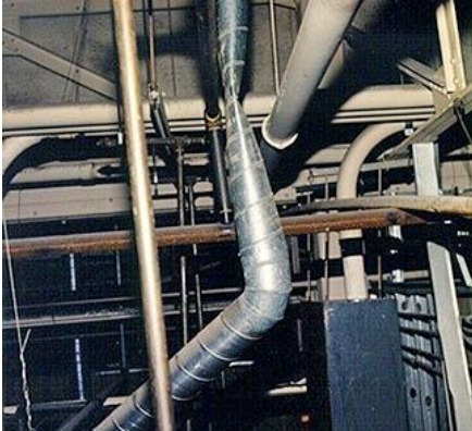
Abb. 2.18.1 > Anprallschaden
