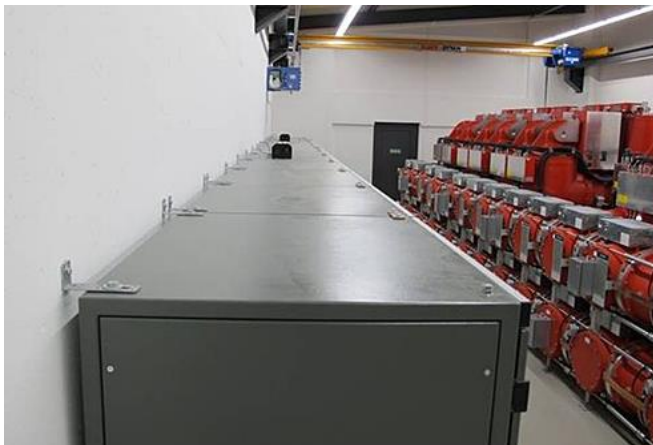
Abb. 2.13.6 und 2.13.7 > Sicherung von Schränken an der Wand
