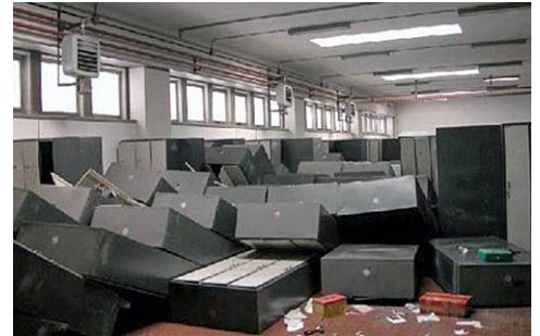
Abb. 2.22.5 und 2.22.6 &gt; Kippen mehrerer Regalreihen infolge des Domino-Effekts
