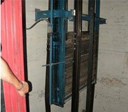
Abb. 2.19.1 > Führungsschiene durch Gegengewichte verbogen
