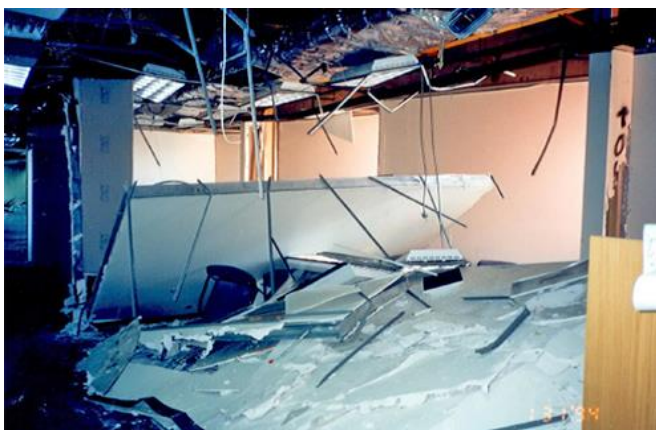
Abb. 2.4.3 und 2.4.4 > Schäden an Leichtbauwänden
